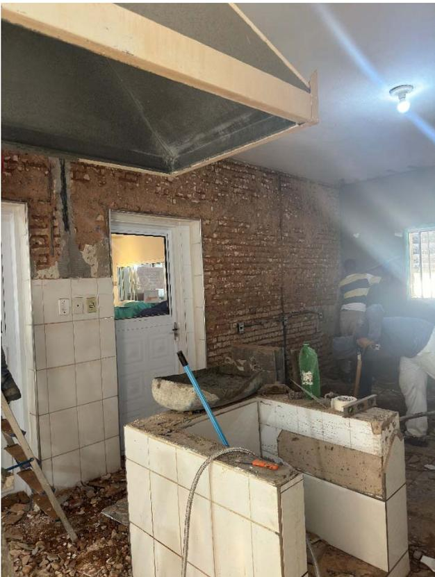
Foto 15: Cozinha, demolição de revestimentos, retirada de bancadas antigas, iniciando base (emboço, reboco) - 16/08/2024.
