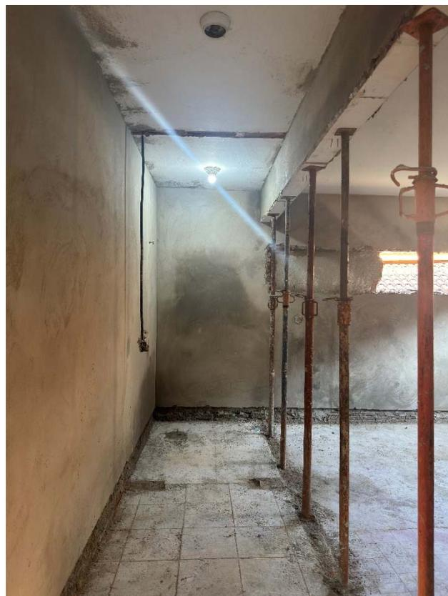
Foto 8: Despensa, escoramento viga estrutural de reforço, viga concretada sem caixarias - 16/08/2024.
