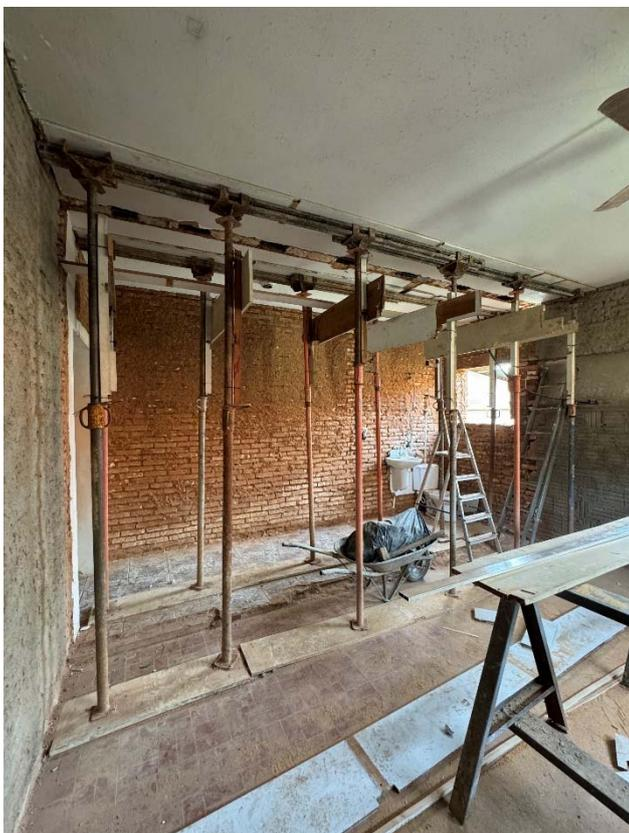
Foto 5: Despensa, escoramento viga estrutural de reforço (antiga parede do banheiro) - 12/08/2024.
