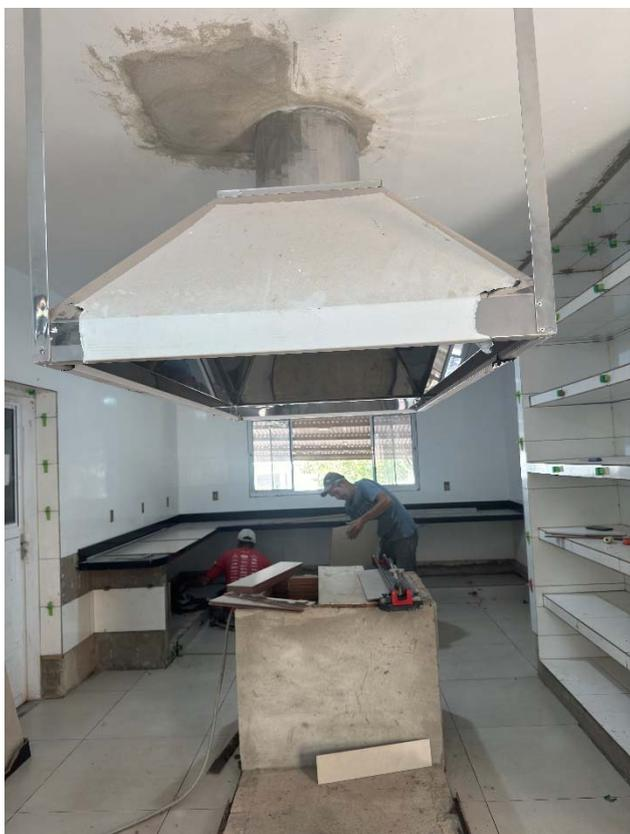
Foto 25: Cozinha, bancadas instaladas, finalizando revestimentos, pisos assentados, coifa pronta - 02/09/2024.
