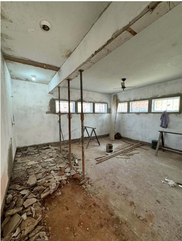
Foto 11: Despensa, demolição do piso e base antiga 22/08/2024.
