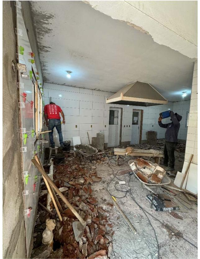
Foto 18: Cozinha, demolição de contrapiso, assentamento de novos revestimentos – 22/08/2024.
