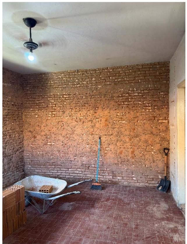
Foto 2: Despensa, retirando o revestimento antigo - 06/08/2024.
