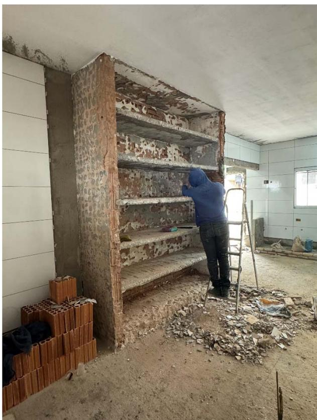
Foto 21: Cozinha, demolição de revestimento armário utensílios – 23/08/2024.
