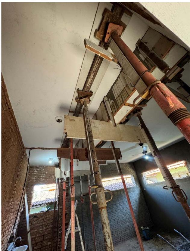
Foto 7: Despensa, escoramento viga estrutural de reforço, viga concretada - 13/08/2024.
