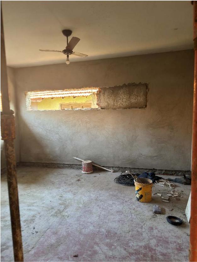
Foto 9: Despensa, emboço e reboco prontos - 16/08/2024.
