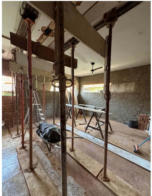
Foto 4: Despensa, escoramento para viga estrutural de reforço - 12/08/2024.
