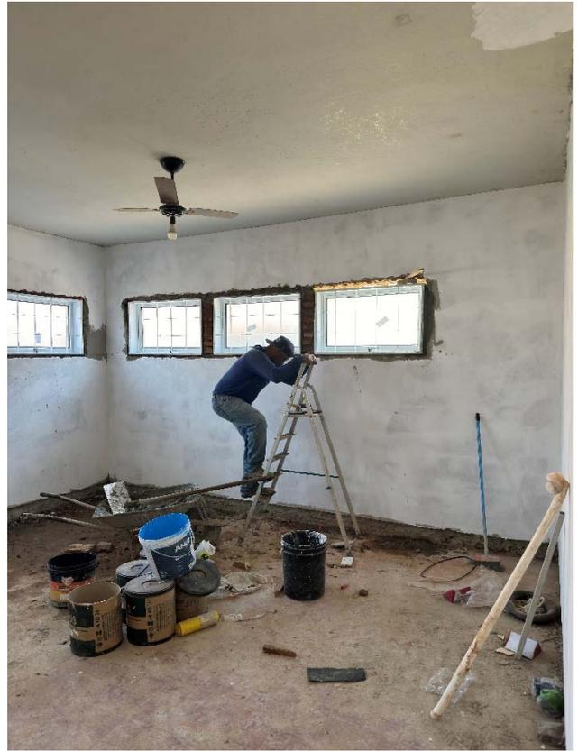
Foto 10: Despensa, emboço e reboco prontos, assentando janelas - 20/08/2024.
