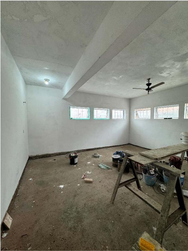
Foto 13: Despensa, emassamento das paredes, contrapiso pronto – 26/08/2024.
