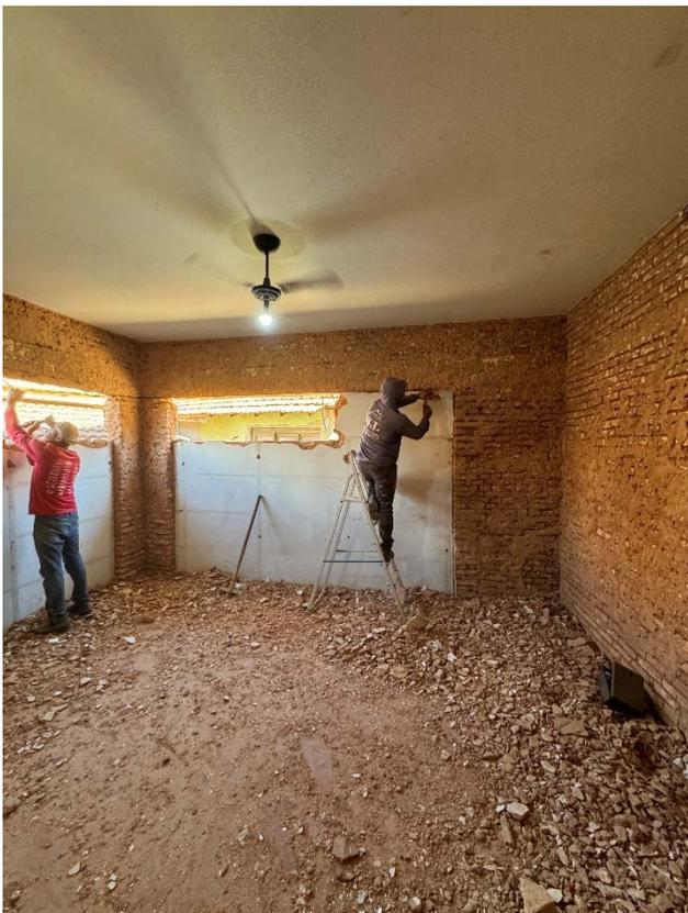
Foto 3: Despensa, retirando o revestimento antigo - 06/08/2024.
