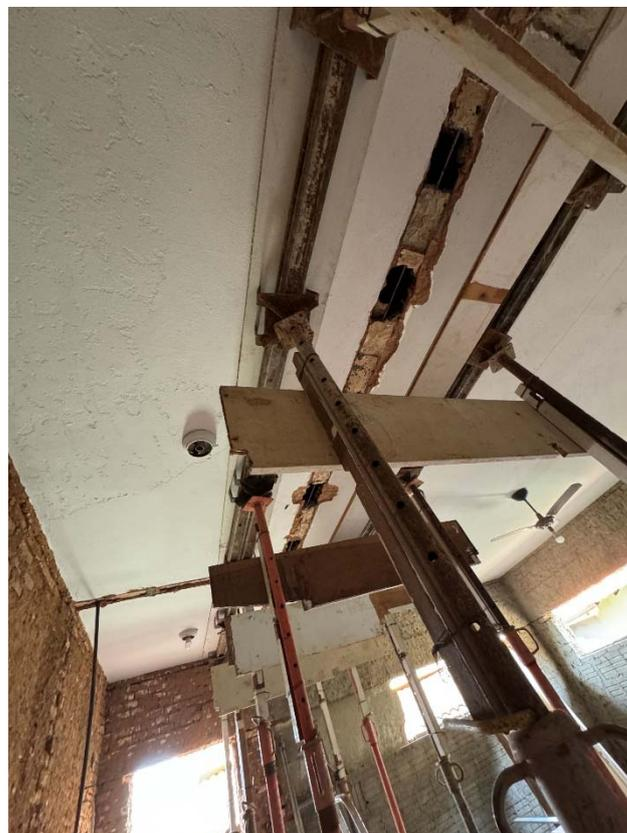
Foto 6: Despensa, escoramento para viga estrutural de reforço - 12/08/2024.
